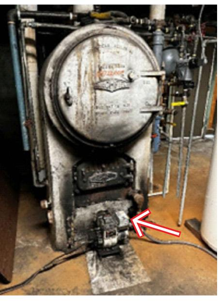
PHOTO 1 LOCATION OF ASBESTOS-CONTAINING GREY BRITTLE PATCH ON BASE OF BOILER
