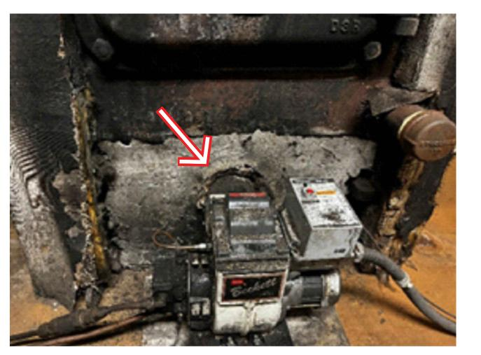
**PHOTO 2** LOCATION OF ASBESTOS-CONTAINING **GREY BRITTLE PATCH ON BASE OF BOILER**
